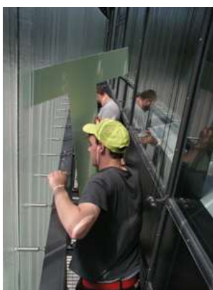
Montáž nápisu „NTK“ na budovu
